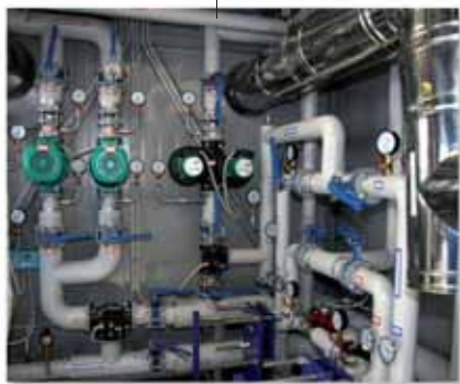
Sistemas industriais de tratamento d'água
